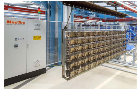
Nach der Reinigung fahren die Gestelle automatisch zum richtigen Entnahmeplatz.
