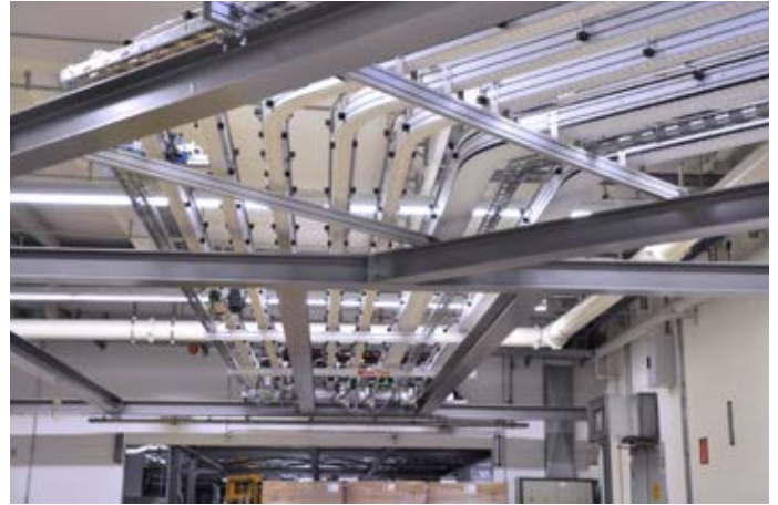
Ein großer Teil der Förderanlage wurde unter der Hallendecke in drei bis fünf Meter Höhe montiert.
