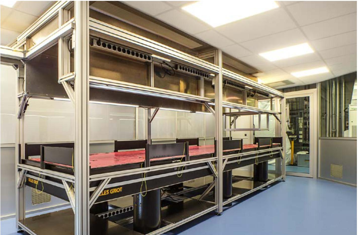
**Reinräume werden an Hochschulen und Forschungsinstituten häufig benötigt, um bestimmte Untersuchungen und Projekte fehlerfrei durchführen zu können. Sie gewährleisten eine sehr geringe Konzentration luftgetragener Teilchen, was in verschiedenen Bereichen, etwa der Halbleiterfertigung oder der Optik- und Lasertechnologie, unabdingbar ist.**
