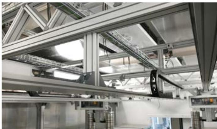
Linearsystem im Deckenbereich für das Handling der Gewichtsketten in der Kammer.
